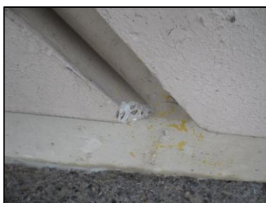
Photo N° 2670 ECH-N°13 30--Façade Murs Béton + peinture
