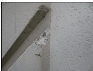
Photo N° 2664 ECH-N°10 32--Façade Murs Béton + peinture
