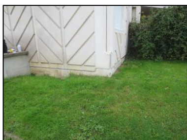
Photo N° 80 ECH-N°140 21 - Façade Mur fondation Béton + peinture
