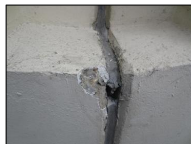
Photo N° 2702 ECH-N°25 3--Façade Murs Béton + peinture
