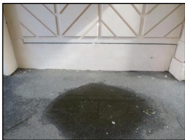
Photo N° 10 ECH-N°74 32 - Porche 30-32 Soubassement - Mur gauche Béton + peinture
