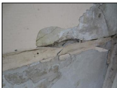
Photo N° 2674 ECH-N°15 30--Façade Murs Béton + peinture
