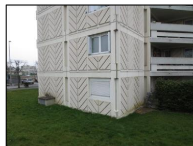
Photo N° 2737 ECH-N°41 19--Façade Murs Joint de dilatation + mousse
