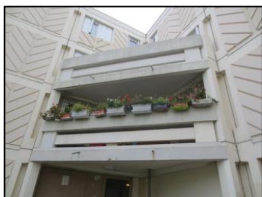
Photo N° 78 ECH-N°138 21 - Balcon Façade Béton + peinture grise
