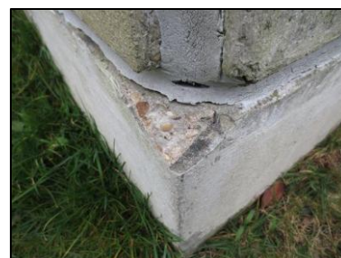
Photo N° 2724 ECH-N°36 7--Façade Murs Béton + peinture
