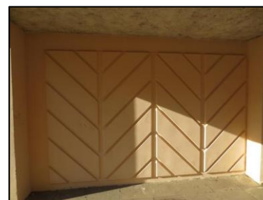
Photo N° 66 ECH-N°126 5 - Porche 3 / 5 Mur hachuré Béton + peinture
