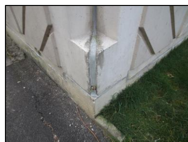
Photo N° 2693 ECH-N°20 1--Façade Murs Joint de dilatation + mousse
