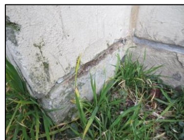
Photo N° 2678 ECH-N°17 28--Façade Murs Joint de dilatation + mousse
