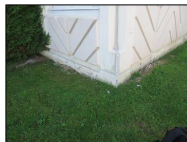
Photo N° 71 ECH-N°131 19 - Façade Mur fondation Béton + peinture
