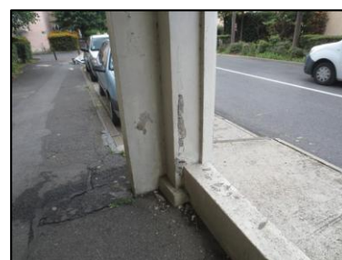
Photo N° 28 ECH-N°89 28 - Porche Rue Poteau Béton + peinture beige
