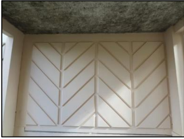
Photo N° 9 ECH-N°73 32 - Porche 30-32 Mur hachuré Béton + peinture
