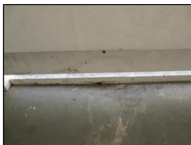
Photo N° 48 ECH-N°109 3 - Balcon +4 Jardinière Béton + peinture blanche
