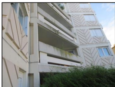
Photo N° 72 ECH-N°132 19 - Balcon Façade Béton + peinture grise
