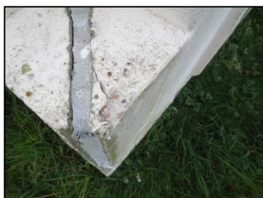
Photo N° 2735 ECH-N°39 21--Façade Murs Béton + peinture
