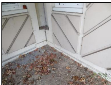
Photo N° 24 ECH-N°86 28 - Façade Mur fondation Béton + peinture
