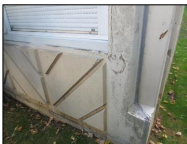
Photo N° 57 ECH-N°117 7 - Façade Mur hachuré Béton + peinture
