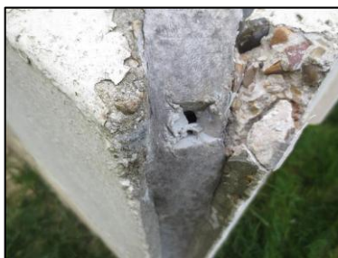
Photo N° 2743 ECH-N°43 19--Façade Murs Joint de dilatation + mousse
