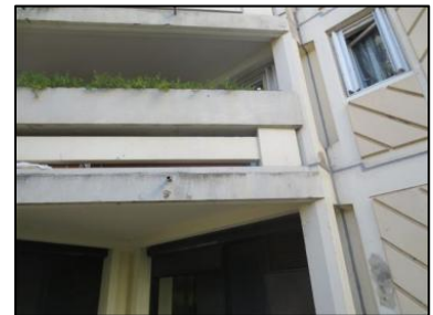
Photo N° 46 ECH-N°107 3 - Façade Mur fondation Mortier + peinture
