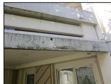
Photo N° 16 ECH-N°79 --30 - Balcon Mur façade Béton + peinture grise
