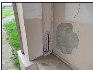
Photo N° 2705 ECH-N°26 3--Façade Murs Béton + peinture
