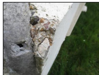
Photo N° 2744 ECH-N°44 19--Façade Murs Béton + peinture
