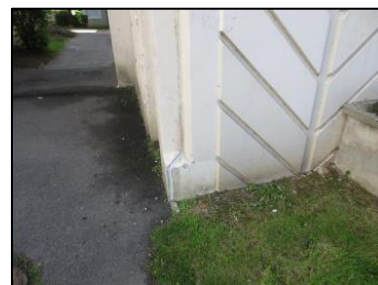
Photo N° 22 ECH-N°85 28 - Façade Mur Béton + peinture beige
