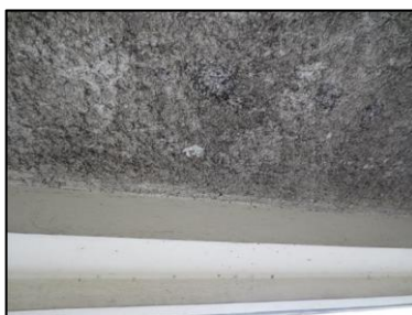
Photo N° 2654 ECH-N°4 FLOCAGE 32--Porche Plafond Flocage
