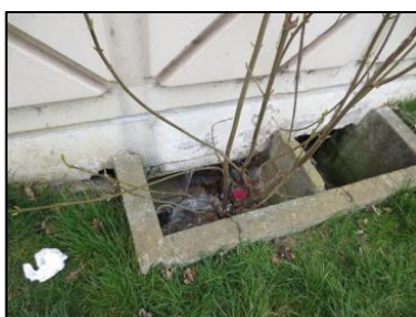
Photo N° 2713 ECH-N°30 AMIANTE CIMENT 5--Façade Conduit accès vide sanitaire Ventilation (Fibres-ciment)
