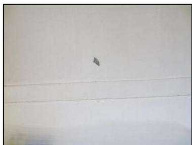
Photo N° 20 ECH-N°82 --30 - Porche 28-30 Mur Béton + peinture
