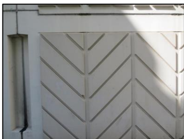
Photo N° 14 ECH-N°77 30--Façade Mur hachuré Béton + peinture beige
