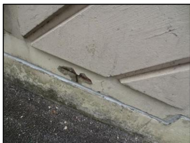
Photo N° 2694 ECH-N°21 1--Façade Murs Béton + peinture
