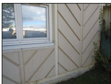
Photo N° 33 ECH-N°94 1 - Façade Mur hachuré Béton + peinture
