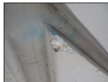
Photo N° 2650 ECH-N°3 32--Façade Murs Béton + peinture
