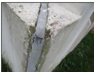
Photo N° 2736 ECH-N°40 21--Façade Murs Joint de dilatation + mousse
