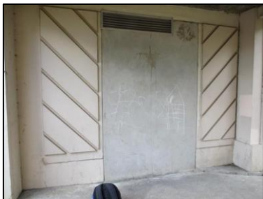
Photo N° 41 ECH-N°102 3 - Porche 3/7 Mur hachuré Béton + peinture
