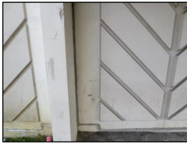
Photo N° 4 ECH-N°68 32-Porche RUE Mur Béton + peinture beige
