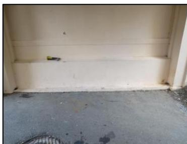
Photo N° 21 ECH-N°83 --30 - Porche 28-30 Soubassement - Mur gauche Béton + peinture
