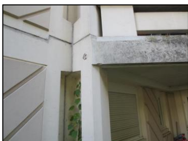
Photo N° 36 ECH-N°97 1 - Balcon Façade Béton + peinture grise
