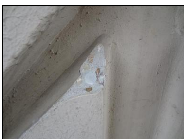
Photo N° 2657 ECH-N°6 32--Façade Murs Béton + peinture
