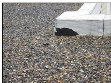
Photo N° 2802 ECH-N°56 REVETEMENT DE SOL 19--Toiture-terrasse Etanchéité Pax alu
