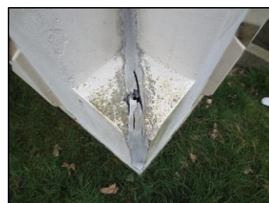
Photo N° 2714 ECH-N°31 5--Façade Murs Joint de dilatation + mousse
