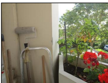
Photo N° 53 ECH-N°114 7 - Balcon +1 Porte 7015 Poteau Béton + peinture beige
