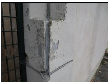
Photo N° 2697 ECH-N°22 1--Façade Murs Joint de dilatation + mousse
