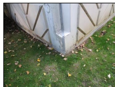
Photo N° 55 ECH-N°115 7 - Façade Mur Béton + peinture beige
