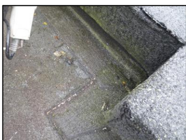
Photo N° 2754 ECH-N°48 REVETEMENT DE SOL 32--Toiture terrasse Etanchéité Bitume
