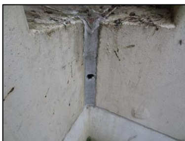
Photo N° 2706 ECH-N°27 3--Façade Murs Joint de dilatation + mousse
