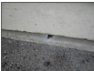
Photo N° 2651 ECH-N°2 32--Façade Murs Joint de dilatation + mousse
