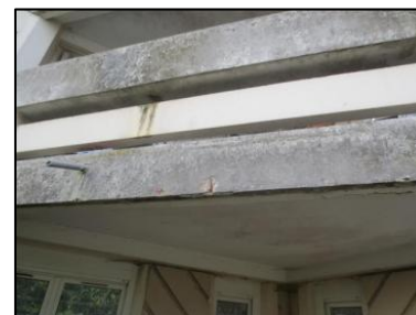
Photo N° 25 ECH-N°87 28 - Balcon Mur façade Béton + peinture grise
