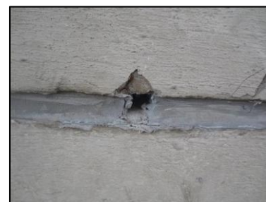
Photo N° 2656 ECH-N°5 32--Façade Murs Joint de dilatation + mousse
