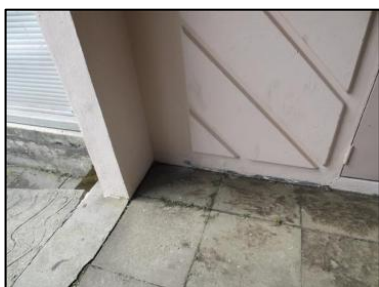
Photo N° 30 ECH-N°91 28 - Porche 28/1 Mur fondation Béton + peinture
