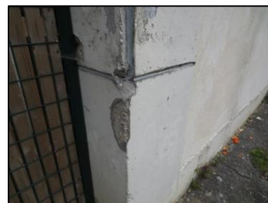
Photo N° 2698 ECH-N°23 1--Façade Murs Béton + peinture
