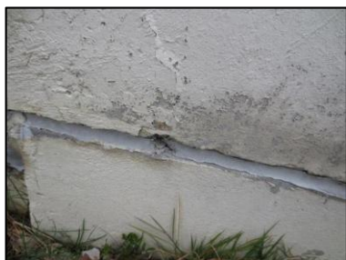
Photo N° 2663 ECH-N°9 32--Façade Murs Joint de dilatation + mousse
