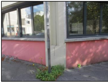
Photo N° 39 ECH-N°100 3 - Façade Mur Béton + peinture
