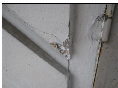
Photo N° 2681 ECH-N°19 28--Façade Murs Béton + peinture
