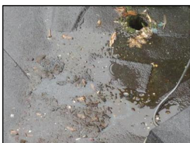
Photo N° 2761 ECH-N°51 REVETEMENT DE SOL 28--Toiture - terrasse Etanchéité Bitume
