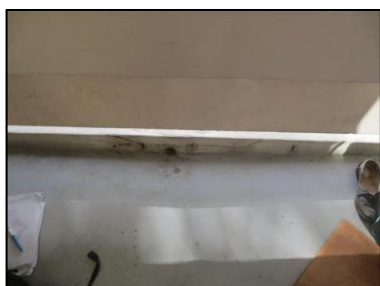
Photo N° 52 ECH-N°113 7 - Balcon +1 Porte 7015 Mur Jardinière Béton + peinture grise
