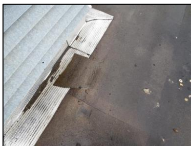
Photo N° 2782 ECH-N°54 REVETEMENT DE SOL 3--Toiture- terrasse Etanchéité Bitume
