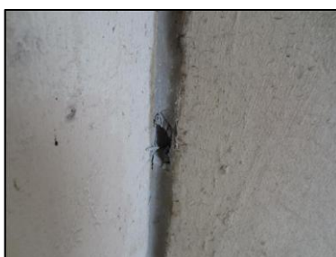
Photo N° 2660 ECH-N°7 32--Façade Murs Joint de dilatation + mousse
