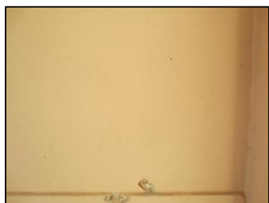
Photo N° 64 ECH-N°124 5 - Porche 3 / 5 Mur Béton + peinture
