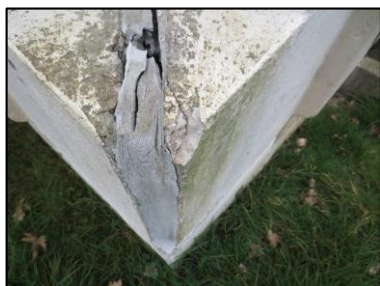
Photo N° 2715 ECH-N°32 5--Façade Murs Béton + peinture
