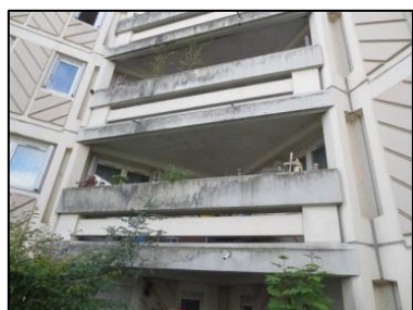
Photo N° 7 ECH-N°71 32- Balcon Façade Béton + peinture grise
