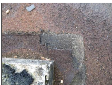
Photo N° 2748 ECH-N°46 REVETEMENT DE SOL 32--Toiture terrasse Etanchéité Bitume
