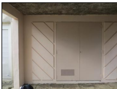
Photo N° 29 ECH-N°90 28 - Porche 28/1 Mur hachuré Béton + peinture
