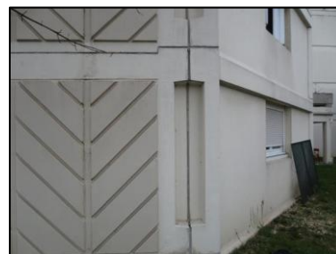
Photo N° 2665 ECH-N°11 32--Façade Murs Béton + peinture
