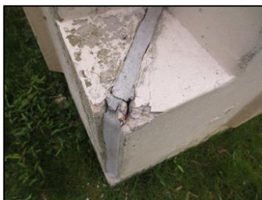
Photo N° 2718 ECH-N°33 7--Façade Murs Béton + peinture
