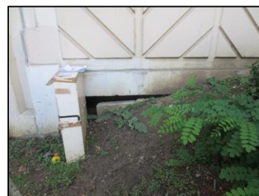
Photo N° 58 ECH-N°118 5 - Façade Mur fondation Béton + peinture
