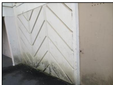
Photo N° 23 ECH-N°84 28 - Façade Mur hachuré Béton + peinture
