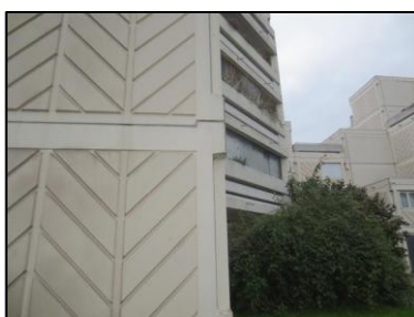
Photo N° 81 ECH-N°141 21 - Façade Mur Béton + peinture beige
