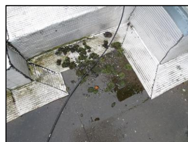
Photo N° 2767 ECH-N°52 REVETEMENT DE SOL 1--Toiture-terrasse Etanchéité Bitume
