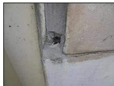
Photo N° 2709 ECH-N°28 5--Façade Murs Joint de dilatation + mousse
