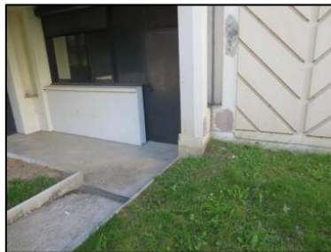
Photo N° 45 ECH-N°106 3 - Balcon Façade Béton + peinture grise
