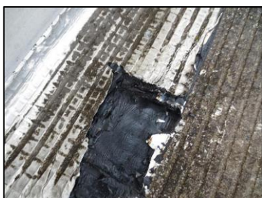
Photo N° 2747 ECH-N°45 REVETEMENT DE SOL 32--Toiture terrasse Etanchéité Pax alu
