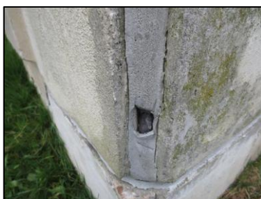
Photo N° 2723 ECH-N°35 7--Façade Murs Joint de dilatation + mousse
