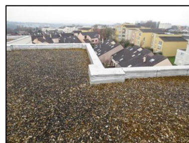
Photo N° 2760 ECH-N°50 REVETEMENT DE SOL 28--Toiture - terrasse Etanchéité Pax alu
