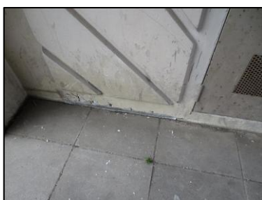
Photo N° 2682 ECH-N°18 28--Façade Murs Joint de dilatation + mousse
