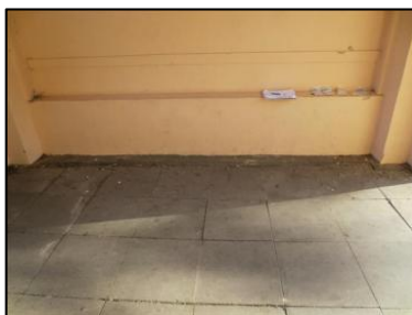
Photo N° 62 ECH-N°122 5 - Porche 3 / 5 Soubassement - Mur Béton + peinture
