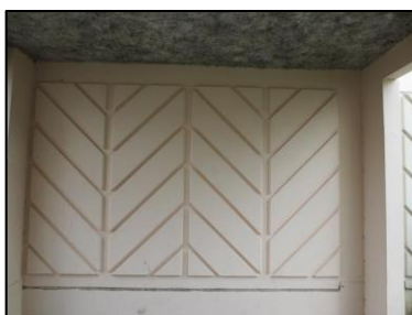
Photo N° 76 ECH-N°136 19 - Porche 19-21 Mur hachuré Béton + peinture
