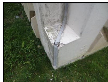
Photo N° 2719 ECH-N°34 7--Façade Murs Joint de dilatation + mousse
