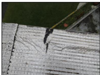
Photo N° 2810 ECH-N°58 REVETEMENT DE SOL 21--Toiture-terrasse Etanchéité Pax alu
