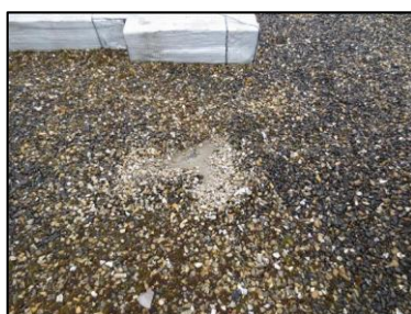
Photo N° 2759 ECH-N°49 REVETEMENT DE SOL 28--Toiture - terrasse Etanchéité sous graviers Bitume
