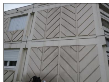
Photo N° 82 ECH-N°142 21 - Façade Mur hachuré Béton + peinture
