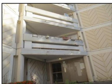
Photo N° 67 ECH-N°127 5 - Balcon Façade Béton + peinture grise
