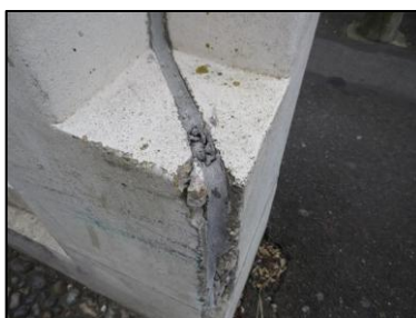
Photo N° 2649 ECH-N°1 32--Façade Murs Joint de dilatation + mousse
