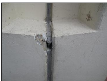
Photo N° 2701 ECH-N°24 3--Façade Murs Joint de dilatation + mousse
