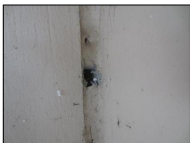
Photo N° 2669 ECH-N°12 30--Façade Murs Joint de dilatation + mousse
