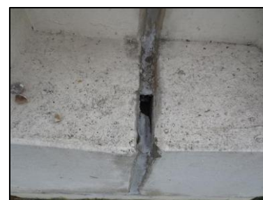
Photo N° 2662 ECH-N°8 32--Façade Murs Joint de dilatation + mousse
