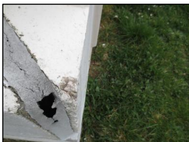
Photo N° 2740 ECH-N°42 19--Façade Murs Béton + peinture
