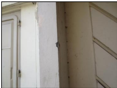
Photo N° 44 ECH-N°105 3 - Porche 3/7 Poteau Béton + peinture
