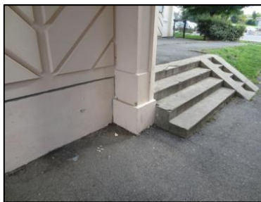
Photo N° 11 ECH-N°75 32 - Porche 30-32 Poteau Béton + peinture
