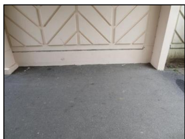
Photo N° 75 ECH-N°135 19 - Porche 19-21 Mur fondation Béton + peinture
