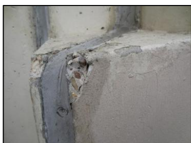
Photo N° 2710 ECH-N°29 5--Façade Murs Béton + peinture
