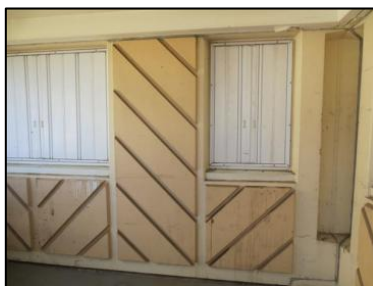
Photo N° 50 ECH-N°111 3 - Balcon +4 Mur hachuré Béton + peinture
