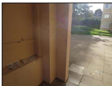
Photo N° 65 ECH-N°125 5 - Porche 3 / 5 Poteau Béton + peinture
