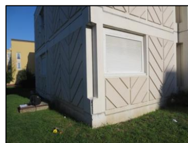
Photo N° 69 ECH-N°129 19 - Façade Mur fondation Béton + peinture
