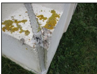
Photo N° 2731 ECH-N°37 21--Façade Murs Béton + peinture
