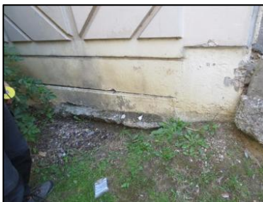
Photo N° 19 ECH-N°81 30--Façade Mur fondation Béton + peinture
