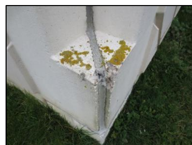
Photo N° 2732 ECH-N°38 21--Façade Murs Joint de dilatation + mousse
